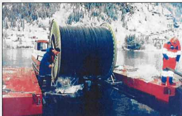
Her har vi lastet cirka 17 tonn. Kabelen er levert av Nexans Norway AS . Vi har leverandører/samarbeidspartnere som skjøter alle slags fiberkabler.
