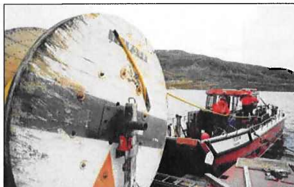
Kabelen kjøres direkte inn på trommel. Det er det samme utstyret som brukes både til opptak og legging.
